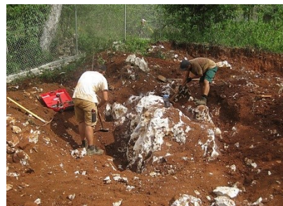
Die Felsbrocken mussten in Handarbeit freigelegt werden
